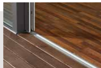
Stufenloser Übergang und nahtloser Anschluss des Terrassenbodens
