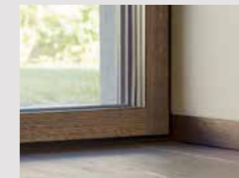
Sockelleiste mit flächenbündigem Wandabschluss
