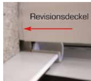
max. Putzkante bei Vorsatzrollläden
